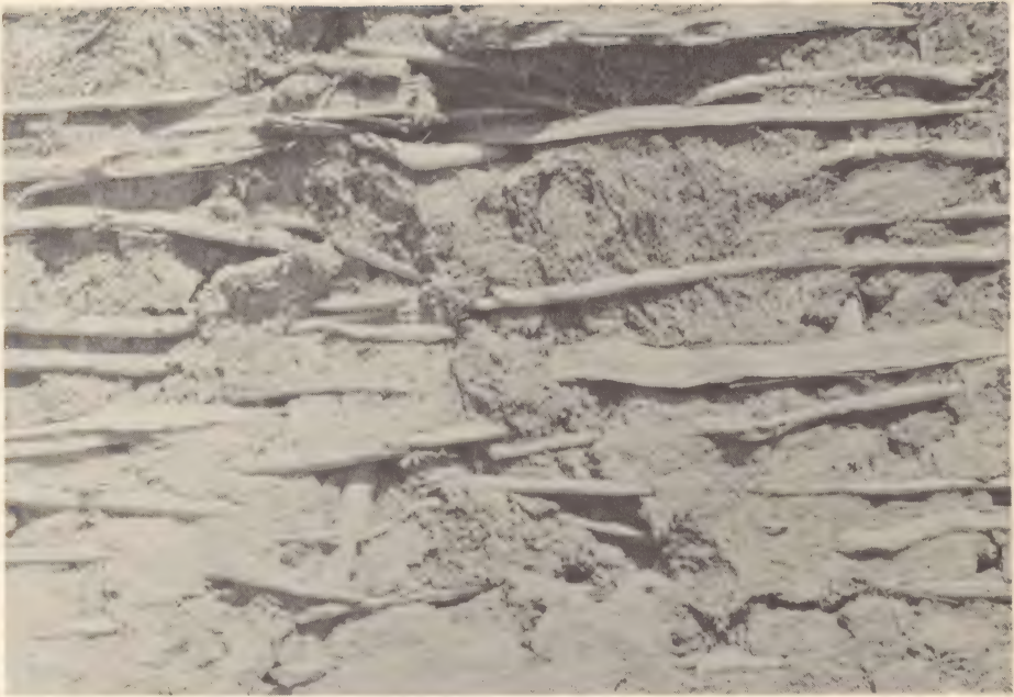
Detail van leemwandconstructie
